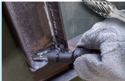
溶接部の ビード除去
